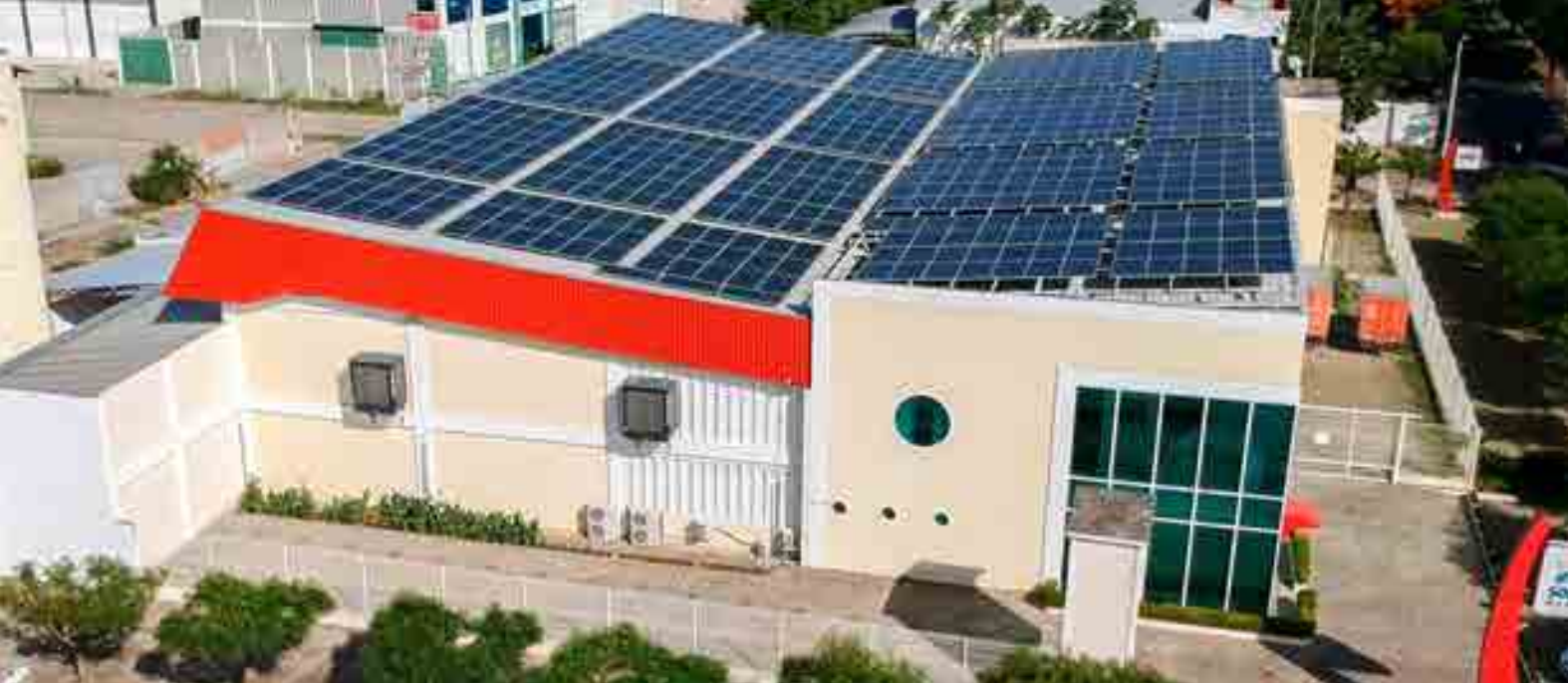
Empresa opera com 100% de energia solar
